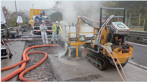
〔橋梁補修工事〕
